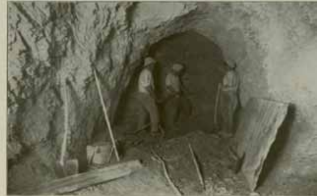
Unione Gallica dell'Appennino - Attorno all'imbocco Nord - Franto dell'arco della sinistra.
